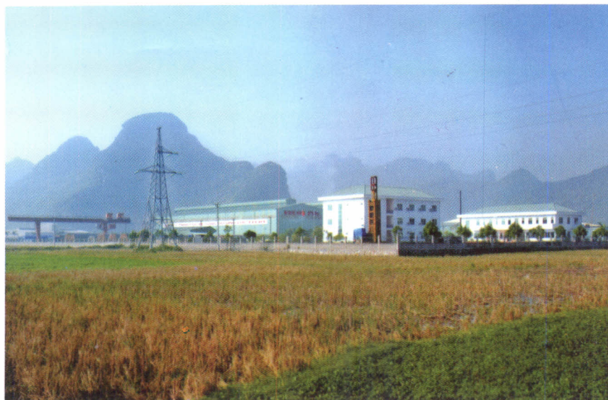
Khu cụm TTCN Thi Sơn xây dựng năm 2002.
